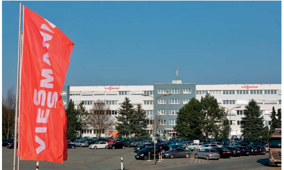
Abbildung 2-1 Viessmann Kühlsysteme Werk in Unterkotzau
